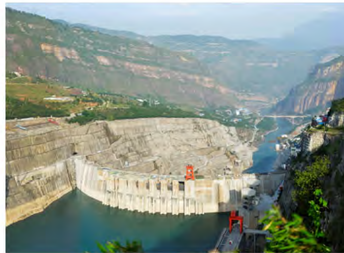
溪洛渡水电站
