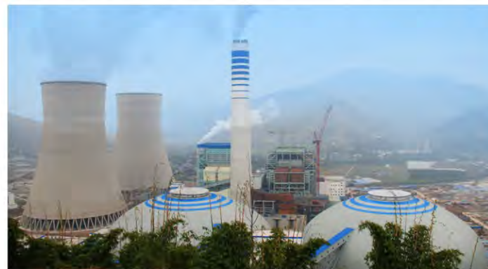
万州电厂全貌
