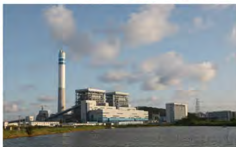
▲ 浙能六横电厂2×1030MW燃煤机组
