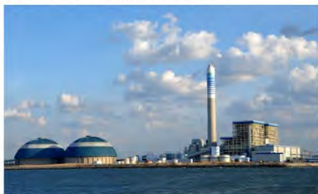
▼ 莱州电厂1000MW超超临界机组
