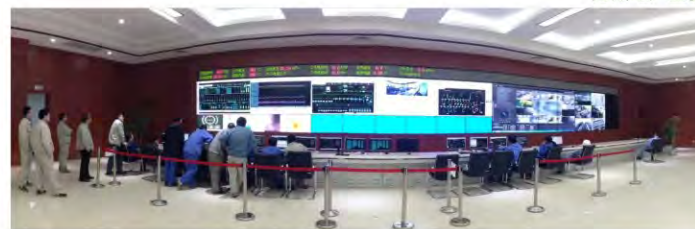
万州电厂主控室
